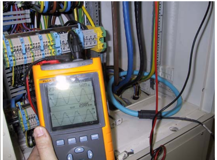
Bild 6 zeigt einen Differenzstrom von 2,08 A
