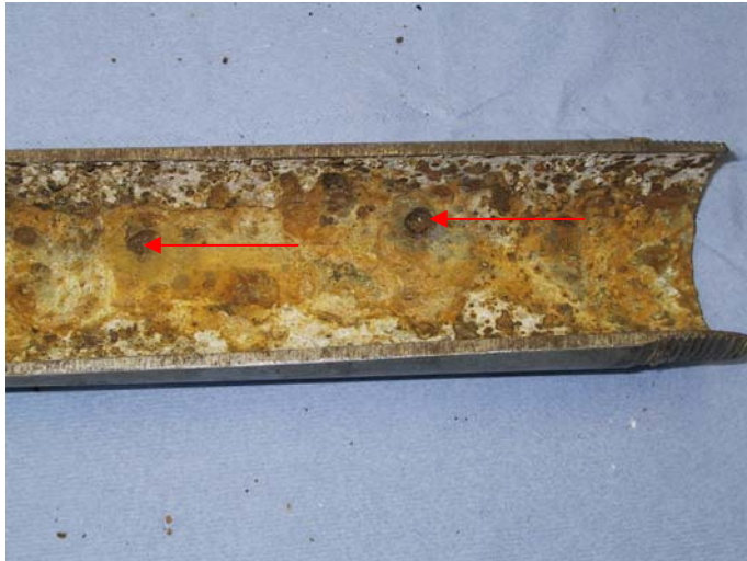
Bild 10 zeigt eine Wasserleitung, die durch einen Wechselstrom korrodiert ist
