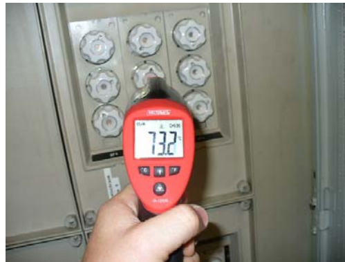
Überhitzte Leitungssicherung
